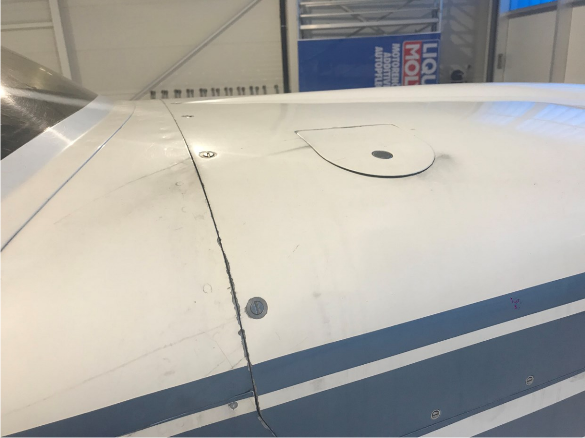
Eingebrannte Verbrennungsrückstände im offenporigen Lack , von vorne nach hinten abschwächend
